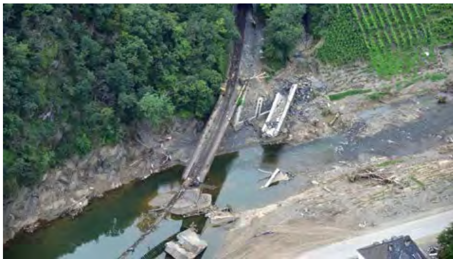
Flutschäden im Ahrtal im Sommer 2021.
