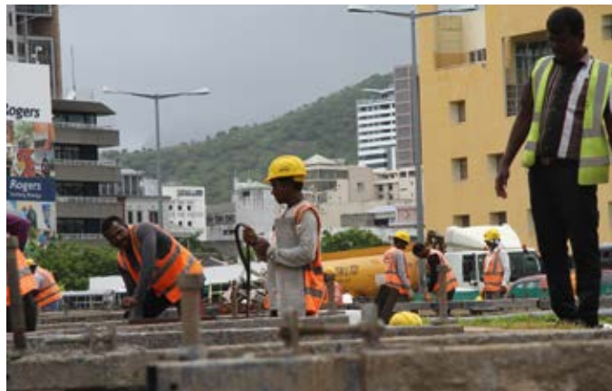
Der Bau einer Stadtbahn ist eine der Maßnahmen, mit denen Mauritius seine Emissionen senken will. Metro-Express-Bau-stelle in der Hauptstadt Port Louis.
