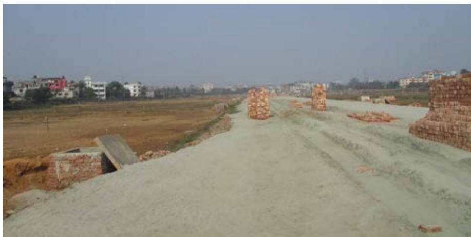
Neue Verkehrsinfrastruktur wirkt sich langfristig aus: Straßenbau im Großraum Dhaka in Bangladesch im Jahr 2017.
