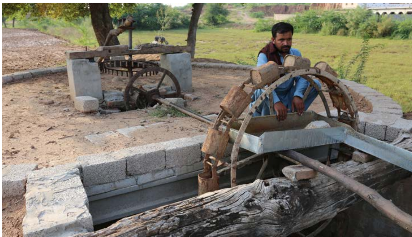
Veraltete Bewässerungsanlage im nördlichen Punjab.
