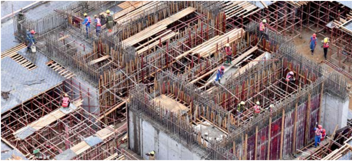
Entwicklung braucht Investition: Großbaustelle in der ruandischen Hauptstadt Kigali.
