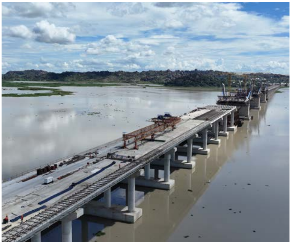
Die Magufuli-Brücke verbindet zwei Regionen Tansanias über den Viktoriasee und wird von der China Civil Engineering Construction Corporation (CCECC) gebaut.
