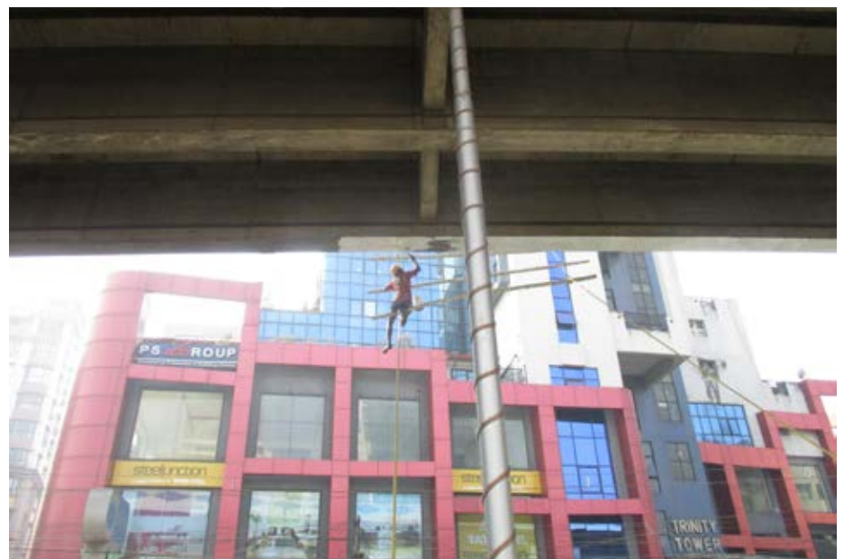
In Indien sind Bauarbeiten in jeder Hinsicht unsicher – Arbeiter in Kalkutta.
