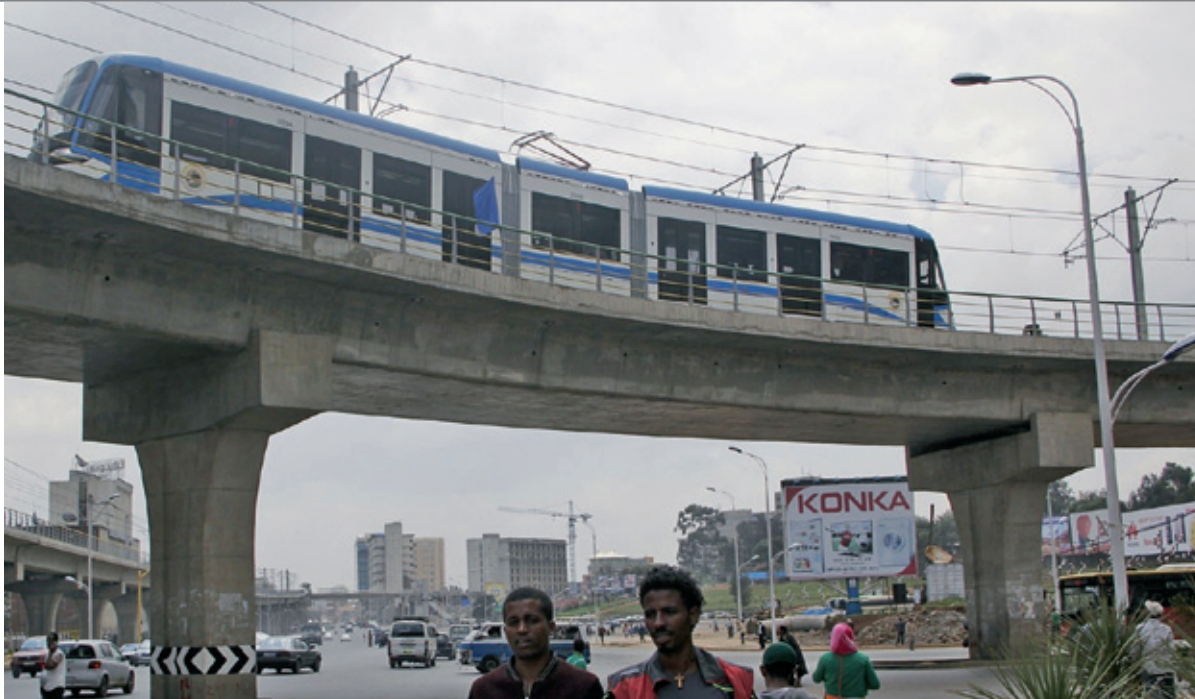
China unterstützt den Ausbau afrikanischer Infrastruktur wie etwa der Stadtbahn in Addis Abeba.
